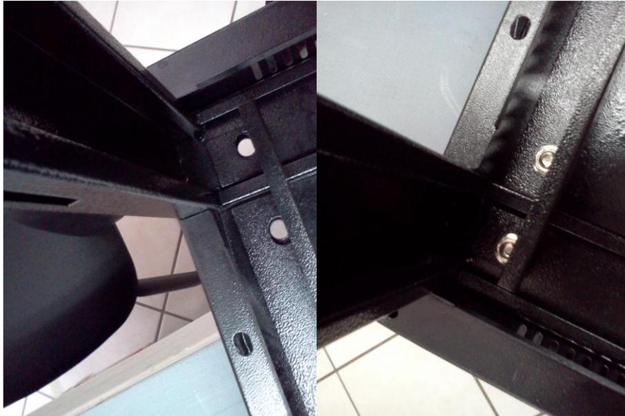
5. Colocación de los tornillos en la base
